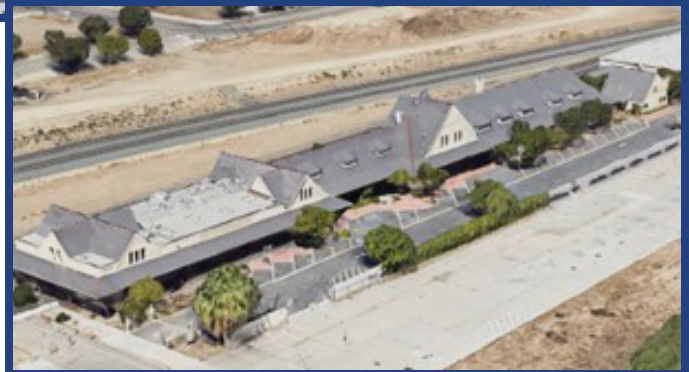
Depósito de tren histórico y cobertizo Pullman: Diseño sísmico y de accesibilidad
